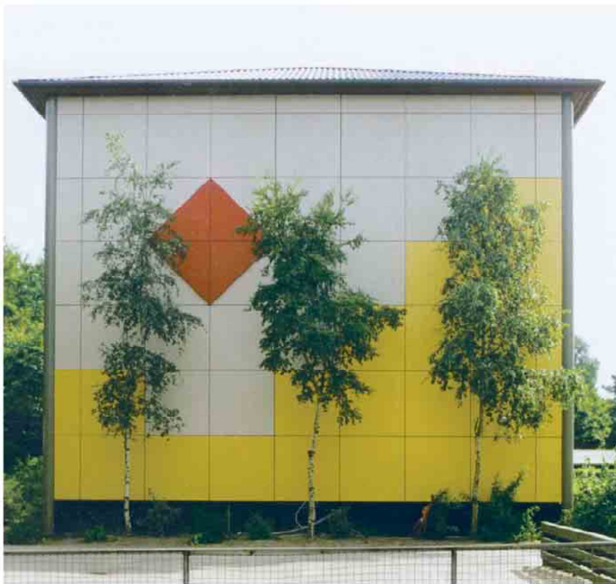
Facaderenovering af otte boligblokke i Hillerød med Trespa.
